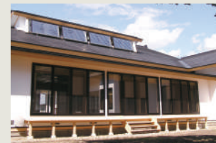
中庭2(太陽熱利用システム)
