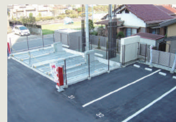
機械式駐車場
