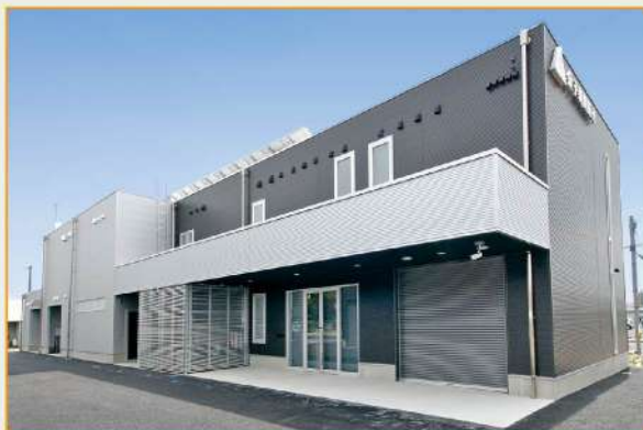
ロードヒーティングが施された社屋北側エントランス
