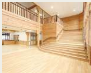
学校の中心を支える高さ7m超のアカマツの大黒柱
