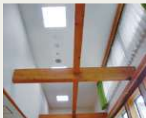
ハイサイドライトの明かりがある廊下の天井
