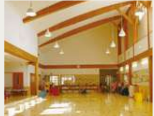
遊戯室(大断面構造集成材45分準耐火構造)
