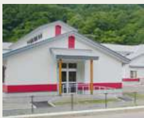
各入居棟ごとの非常口と避難スロープ
