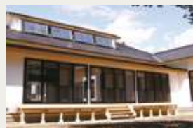
中庭2(太陽熱利用システム)
