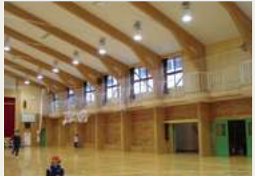
大断面集成材の柱・梁
