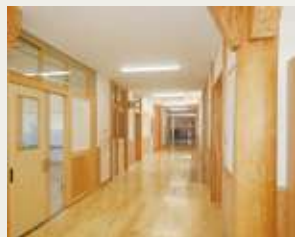
ムクの丸太柱を用いた廊下
