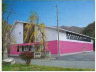
屋内運動場全景（三寸五分勾配の切妻屋根）
