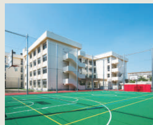
新設した多目的コート・外観北東面
