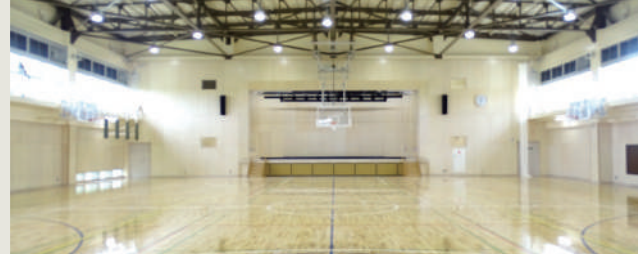
体育館棟 自然風力換気窓を採用した競技場
