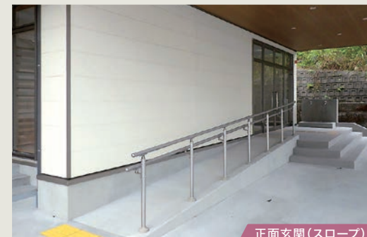
正面玄関(スロープ)
