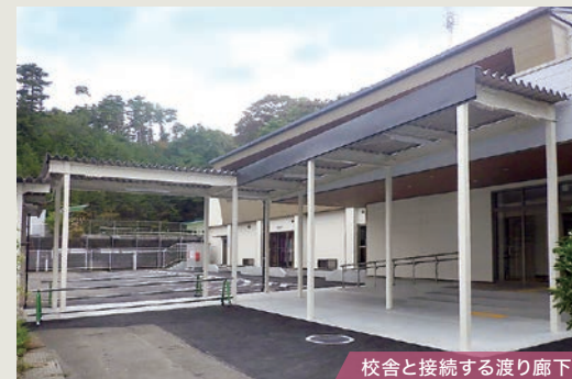
校舎と接続する渡り廊下
